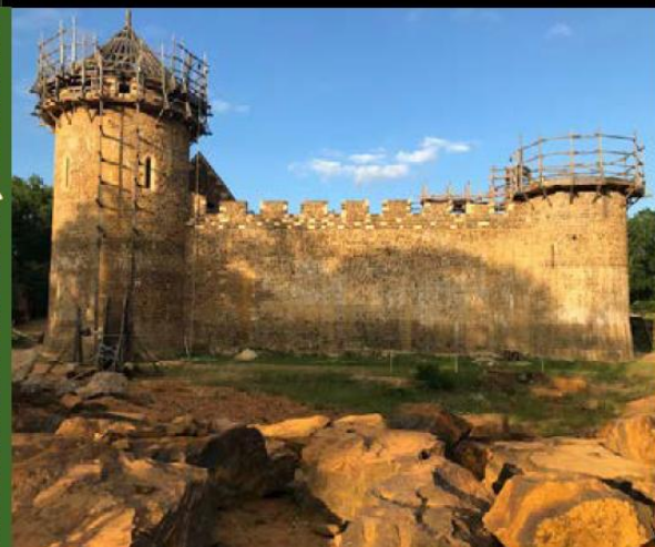
Chantier de Guédelon (89)
